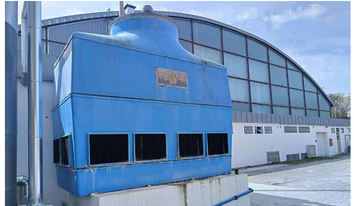
Alter Kühlturm vor dem Rückbau
