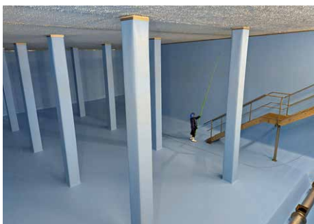
Eine leere Kammer wird durch Stadtwerke-Mitarbeiter desinfiziert
