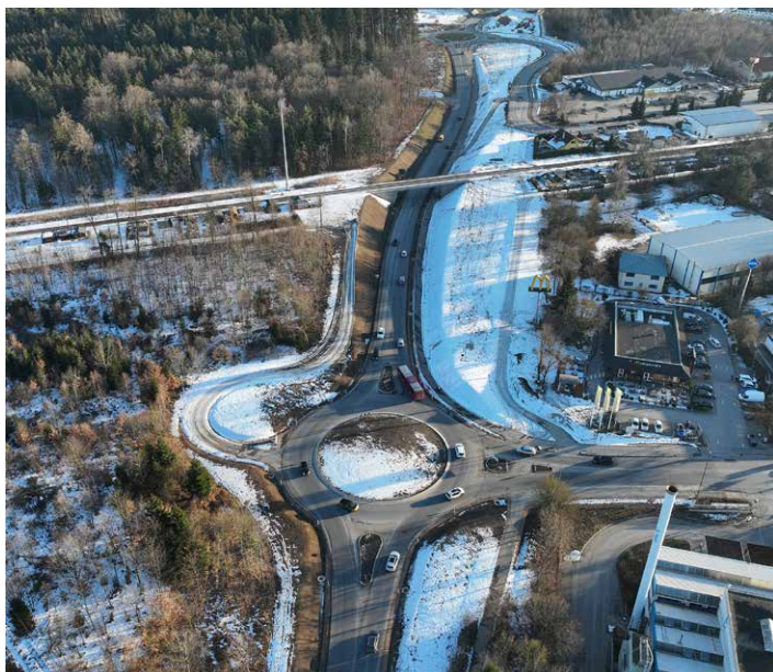
Das Luftbild zeigt den Stand der Arbeiten Mitte Januar 2026!
