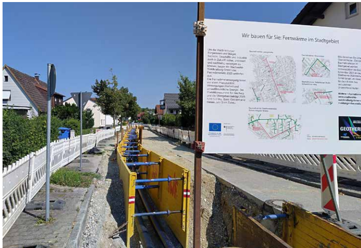
Verlegearbeiten in der Liebigstraße Nord
