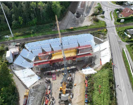
Das Luftbild zeigt den Stand der Arbeiten Mitte September 2025!
