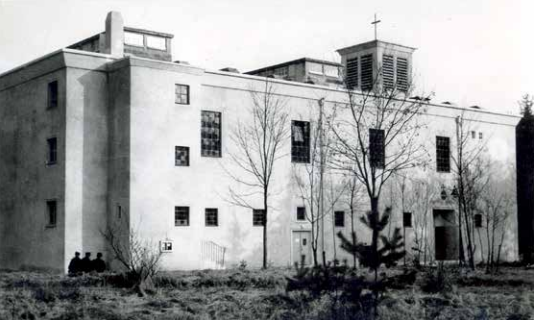
Kath. Bunkerkirche, Ostfassade, am Dach die beiden Oberlichten und das Glockentürmchen.
