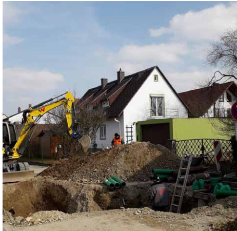
Die Sanierungsarbeiten in der Komotauer Straße schreiten gut voran.
