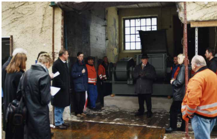
Kleine Feier zum Abschluss der Einbauarbeiten der Knetmaschine im ersten Raum am 12. Dezember 2001, in der Mitte Erster Bürgermeister Jochen Fischer.
