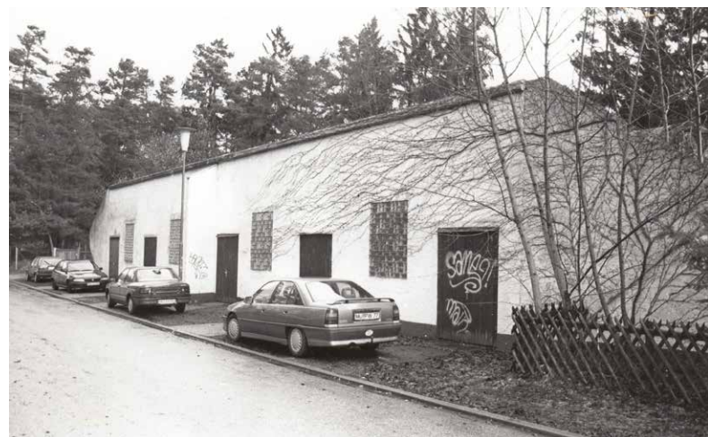
Der Bunker 29 am Schweidnitzer Weg im Bauzustand, als ihn im Jahr 2000 die Stadt Waldkraiburg erwarb.
